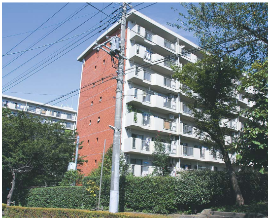
東京都西東京市の西原グリーンハイツ。築39年、8階建て12棟、720戸の大型団地
